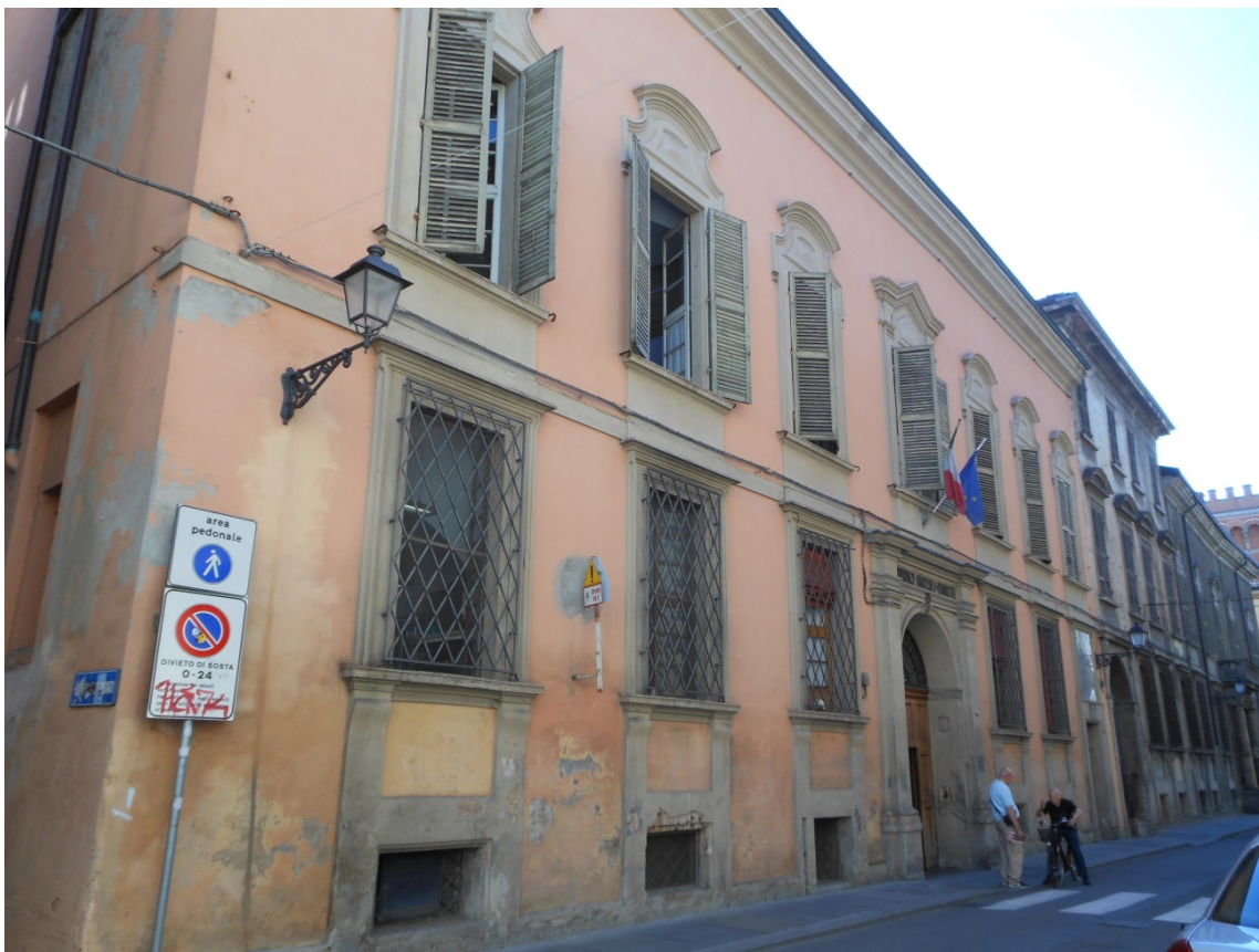
Vista della facciata su via Toschi da ovest
