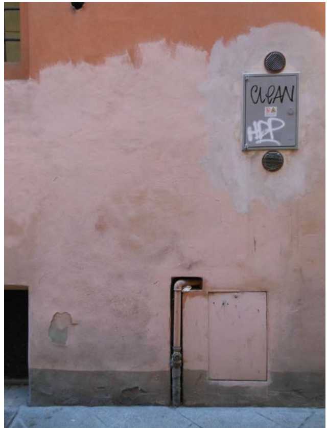
Variazione cromatica dell'intonaco e integrazioni con malta incongrua
