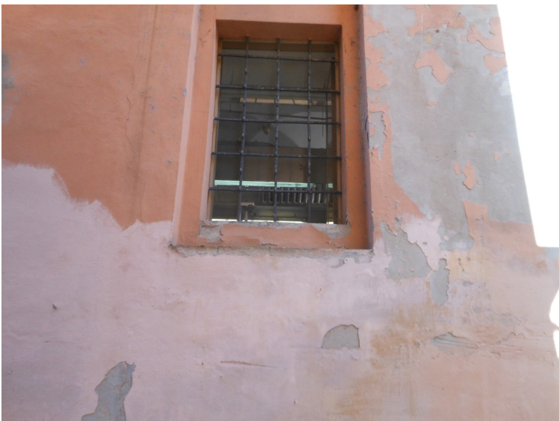
Esfoliazione e variazione cromatica dell'intonaco
