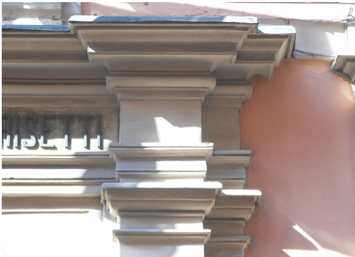
Capitello del portale d'ingresso
