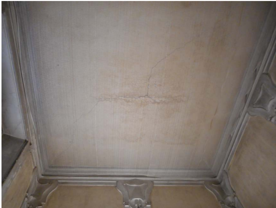
Particolare della struttura estradossale della volta I campata
