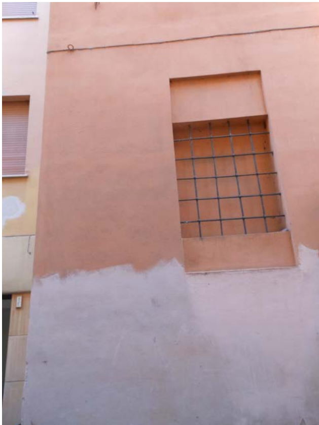
Variazione cromatica dell'intonaco e integrazioni con malta incongrua
