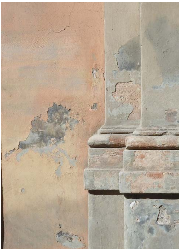
Esfoliazione nel basamento dell'ingresso
