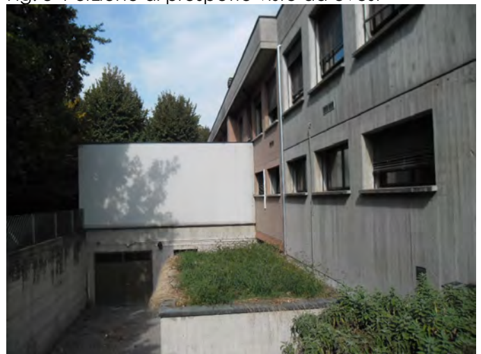
Fig. 10 Porzione di prospetto visto da ovest
