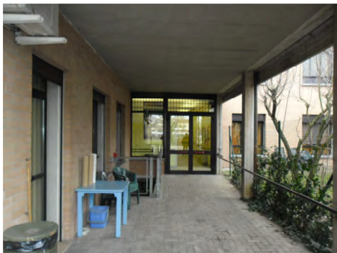
Fig. 13 Porticato lato est
