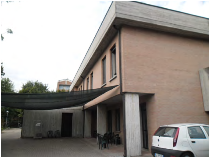
Fig. 7 Porzione di prospetto visto da nord
