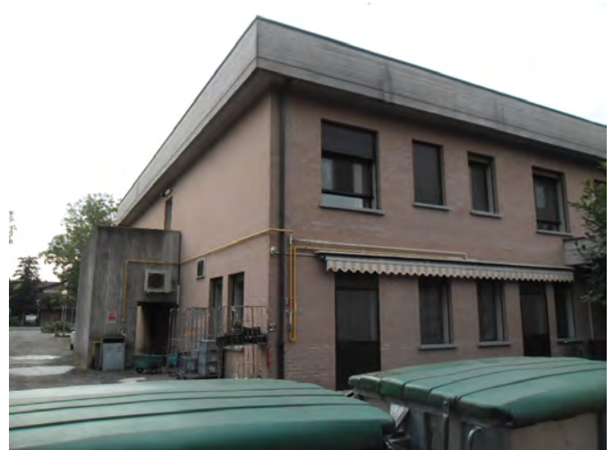
Fig. 8 Porzione di prospetto visto da ovest
