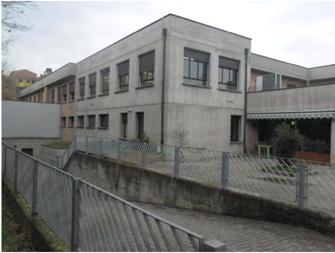
Fig.17 Porzione prospetto SUD-EST
